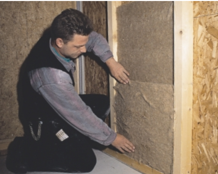
Wärmedämmplatten bestehen schon heute zu über 80 Prozent aus FCKW-freien Materialien. Darüber hinaus bieten sich Materialien aus nachwachsenden Rohstoffen an.
