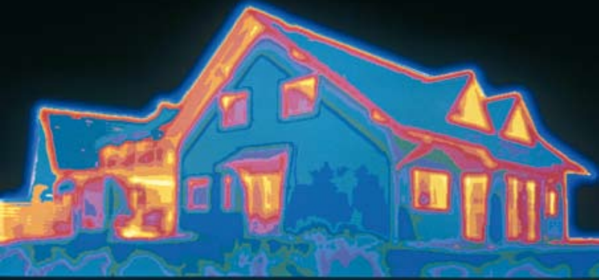
Thermografisches Bild eines Hauses
