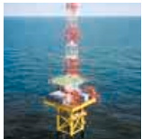
Erste Messplattform rund 45 km nördlich vor Borkum im August 2003 aufgestellt
